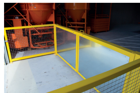
Das Übergabetor im 1. Stock der neuen Lagerhalle verfügt über eine massive Ausführung. Die Verblendung an der Innenseite gibt zusätzliche Sicherheit bei der Warenübergabe
